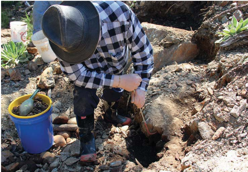
Työkalun terävällä päällä voi rapsuttaa kivien alapintojakin puhtaaksi.
