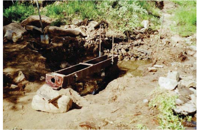
Johda uuden montun maa-aines vanhaan puhdistettuun kuoppaan.
