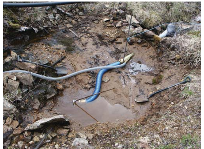
Veden virtaus imurin kautta on niin suuri, ettei pienen puron vesimäärä riitä jatkuvaan työskentelyyn.
