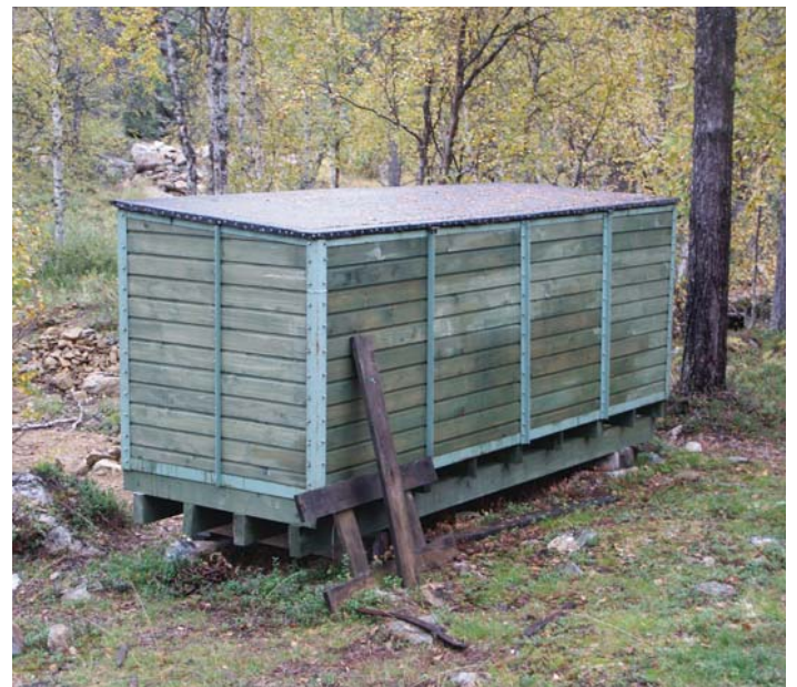
Säilytyslaatikko 1 x 1 x 3 m. Huomaa laatikon sokkeli, jolla estetään pieneläimien pääsy sisälle laatikkoon.
