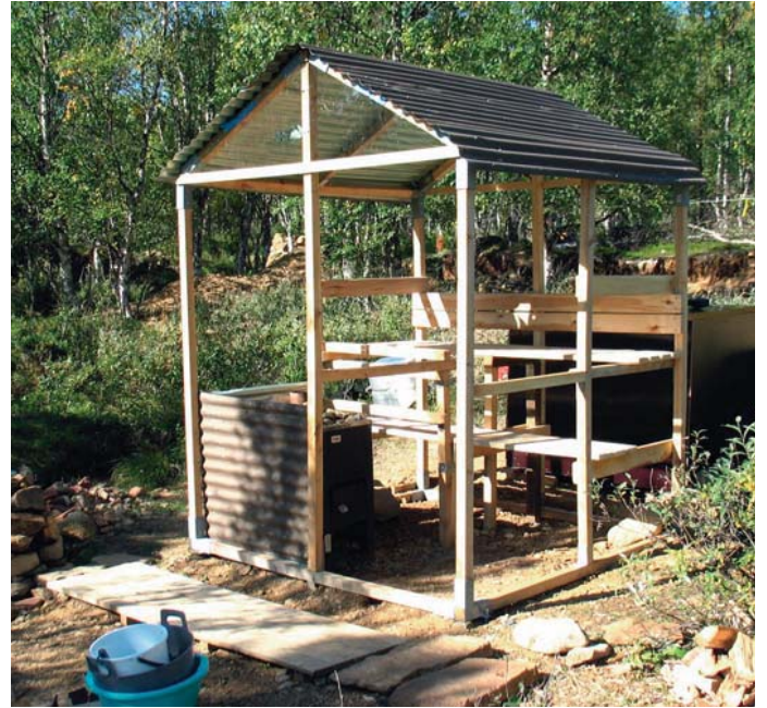
Pressusaunan runko. Kuva Ismo Hellsten.
