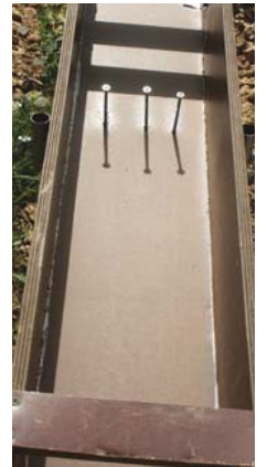
Esteen voi tehdä myös ruuveista, jotka pysäyttävät isommat kivet.
