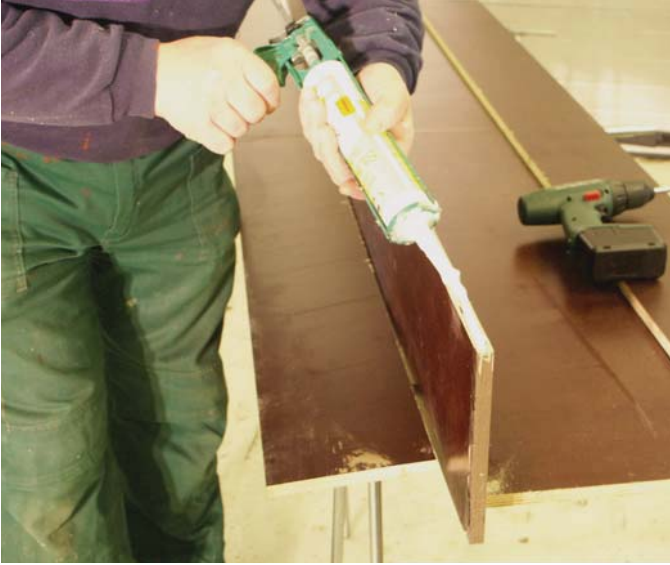
Tiivistä saumat tiivistemassalla ennen kiinnittämistä.
